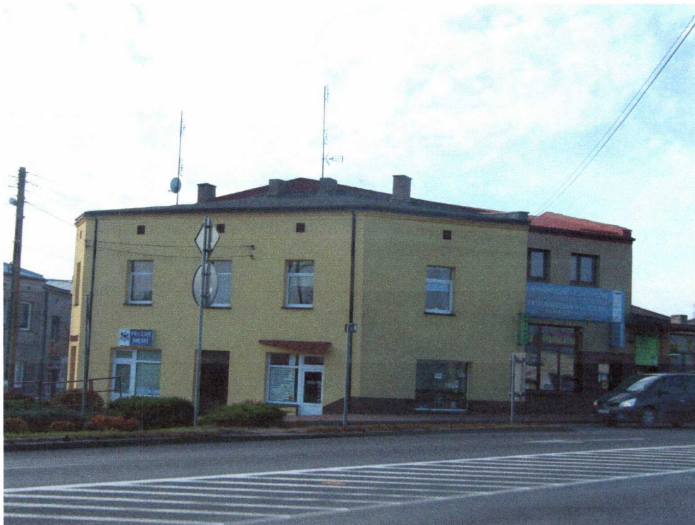
Fot. 1 - Widok elewacji frontowej budynku.
