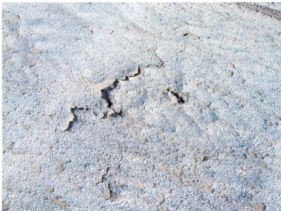
Fot. 16 – Rozszczelnienie pokrycia z papy.
